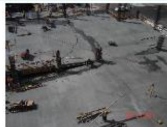
Parking garage concrete pour
